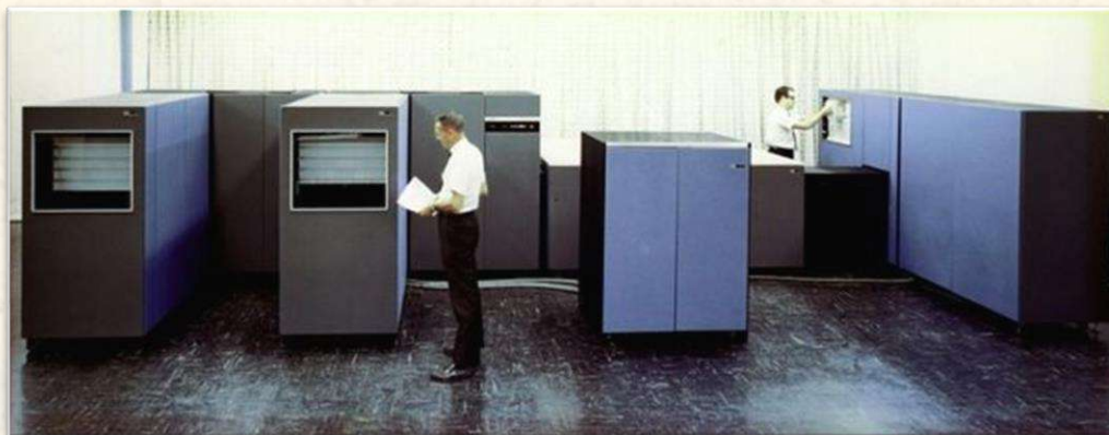
Hình 60. Hệ thống lưu trữ hình ảnh kỹ thuật số IBM 1360 có thể lưu trữ 160GB dữ liệu.
