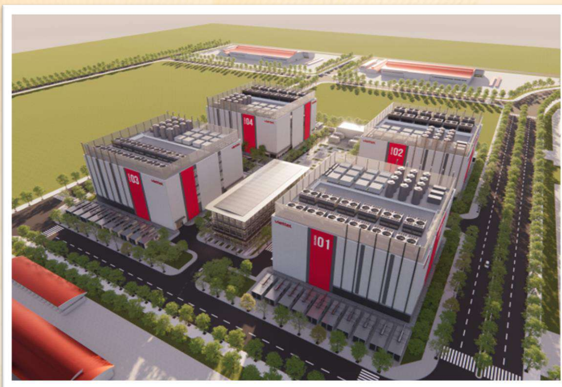
Ảnh dựng khu trung tâm dữ liệu 140 MW của Viettel tại Tân Phú Trung - Ảnh: Viettel
